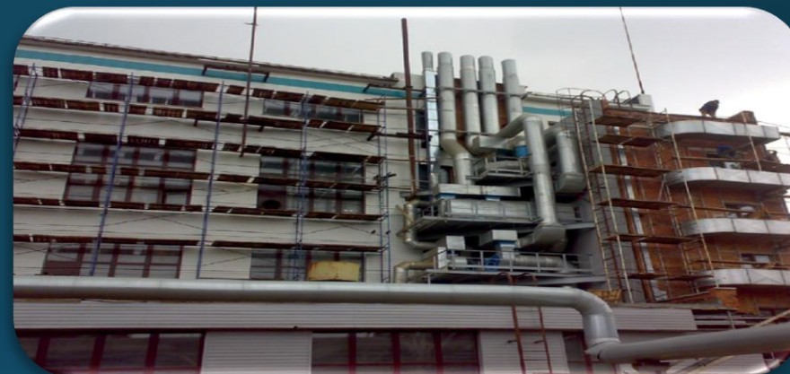
Ремонт фасада здания
