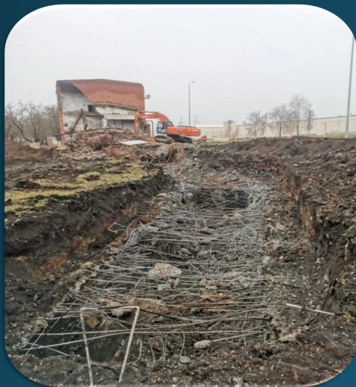
ООО "КНАУФ ГИПС НОВОМОСКОВСК" Демонтаж здания вентиляционной шахты и вентиляционного канала
