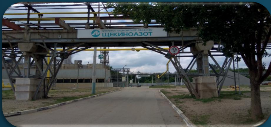
Ремонт технологических эстакад
