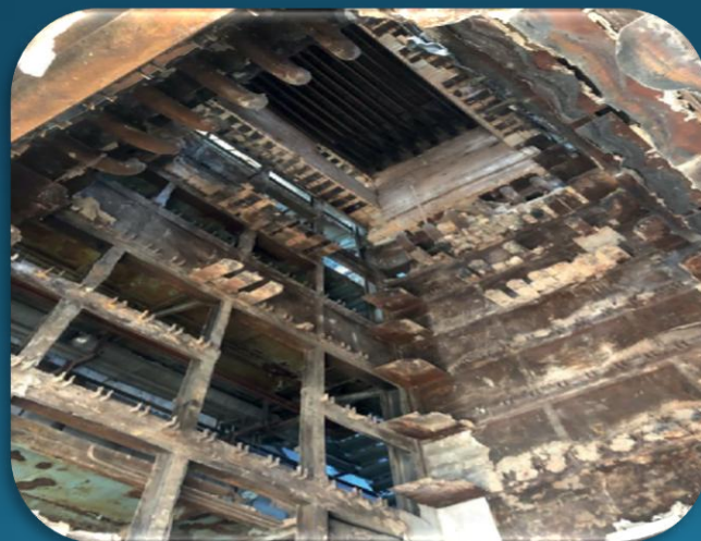
Демонтаж котла цеха УЖиГОП АО «НАК «Азот»
