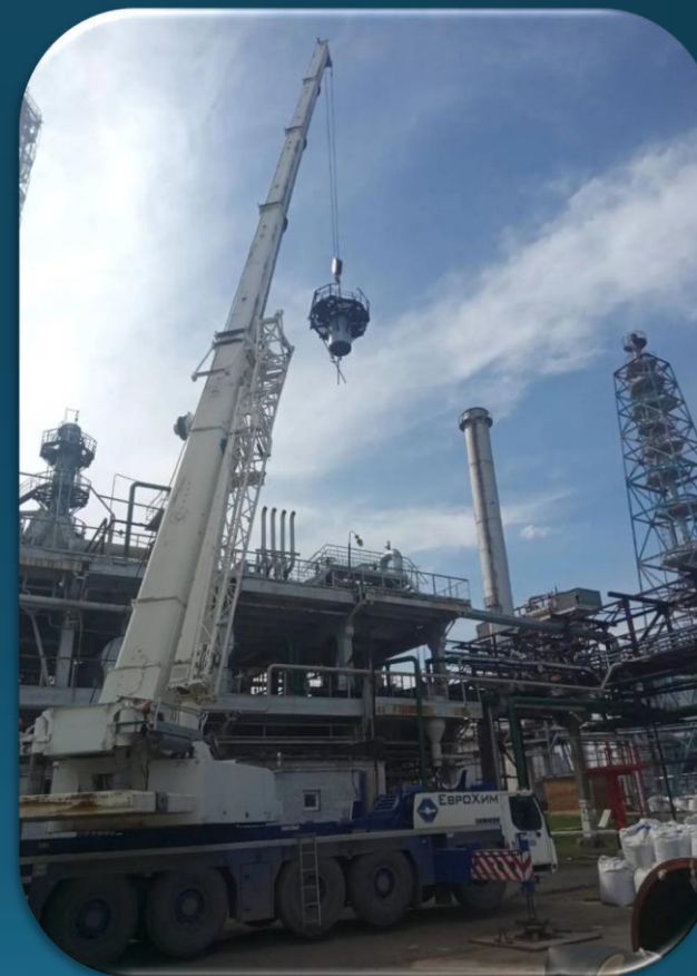
Демонтаж колонны синтеза. АО «НАК «Азот»
