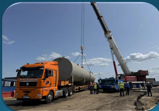
Монтаж технологического оборудования и металлоконструкций ЕТО Новатэк
