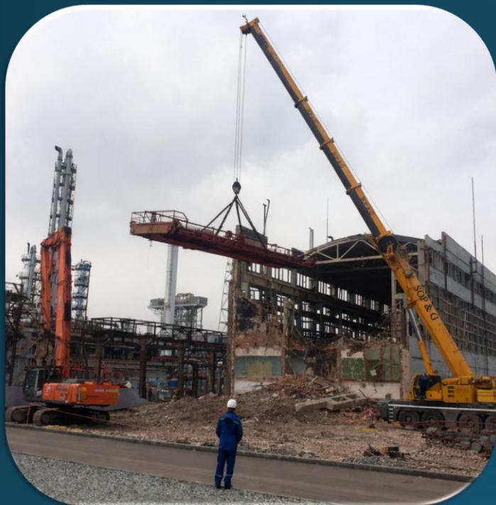
Цех Метанол. Демонтаж оборудования с сохранением. АО «НАК «Азот»
