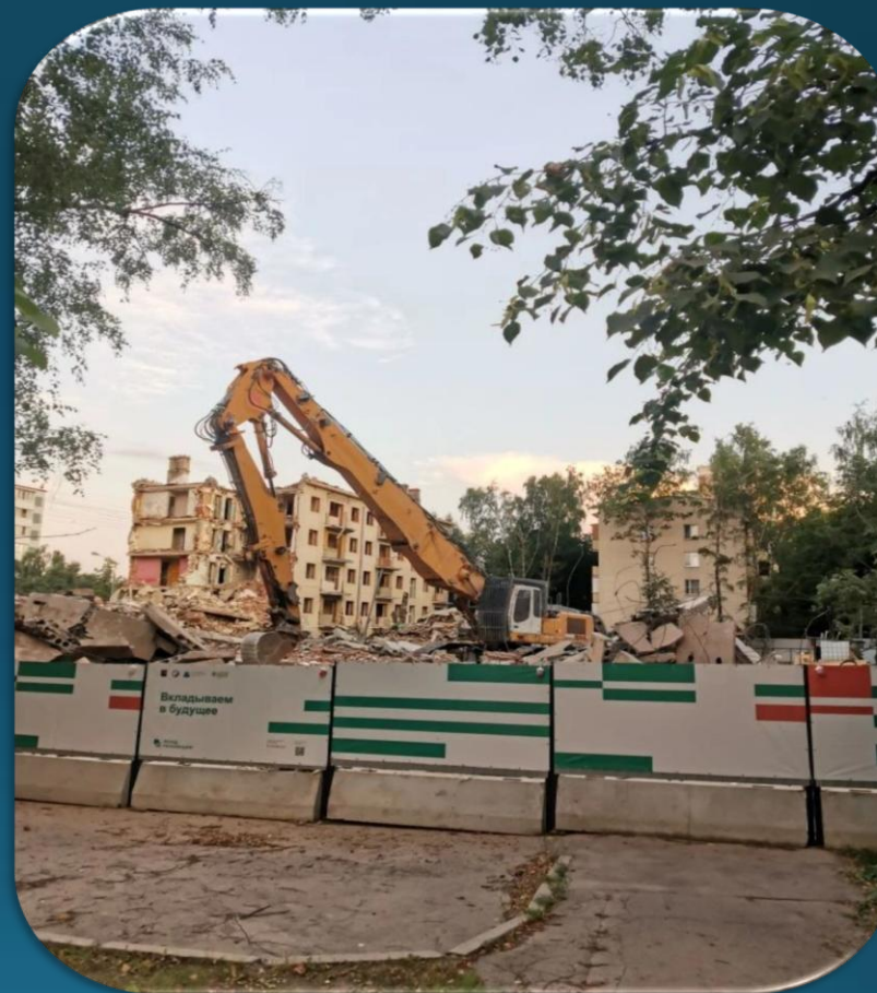
Демонтаж многоквартирного жилья по программе реновации г. Москва
