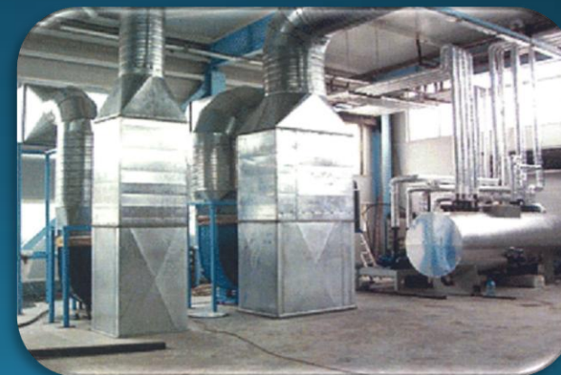
Монтаж систем вентиляции и теплоизоляционные работы на объекте АО «Щекиноазот»
