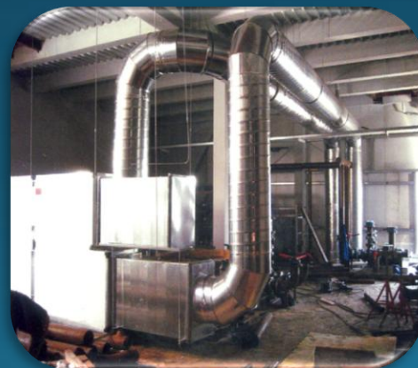
Монтаж систем вентиляции и теплоизоляционные работы на объекте АО «Щекиноазот»
