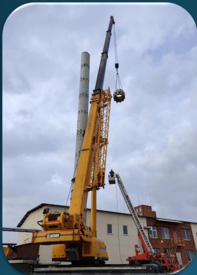
Демонтаж выхлопной трубы ООО «ФМ РУС»
