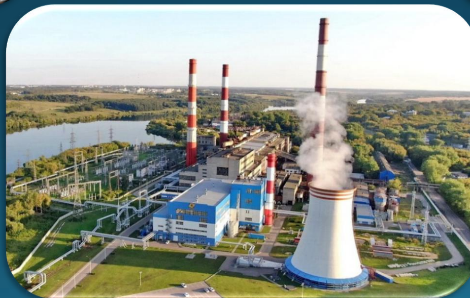
Ремонт котельного оборудования ГРЭС
